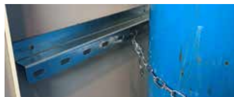
Catena di fissaggio bombole
