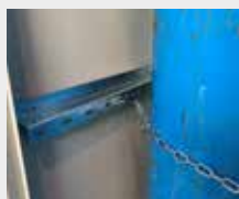
Catene di sicurezza per fissaggio bombola
