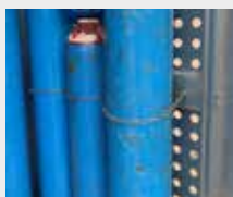
Catene di sicurezza per fissaggio bombola
